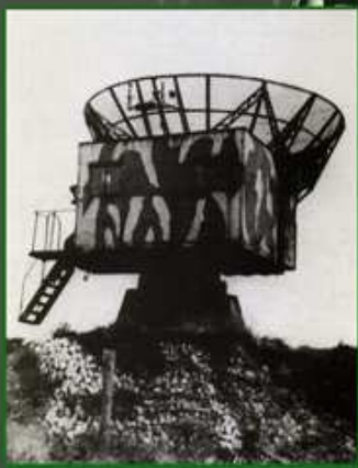
◆ Radar Würzburg-Riese Fumo 214, installé à la pointe de Chazeau, il avait une portée de 600km. © Photo 24
